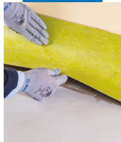
Installazione di sottosguscia e posa di sguscia con Ultrabond Eco Fast Track
